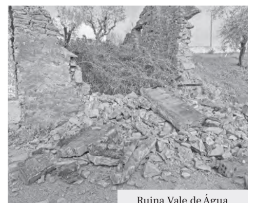
Ruina Vale de Água
